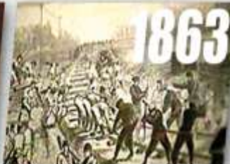
Початок будівництва Одеської залізниці на ділянці Одеса-Балта довжиною 275 кілометрів
